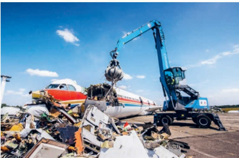
Flugzeugrecycling — Ohne schwere Maschinen und Geräte können Flugzeuge nicht zerlegt werden. Mögliche Ersatzteile wie beispielsweise Trieb- und Fahrwerke müssen fachgerecht ausgebaut werden. Nach der Vorarbeit dauert der Rückbau zwischen zwei und sechs Tagen, je nach Größe des Flugzeuges.
