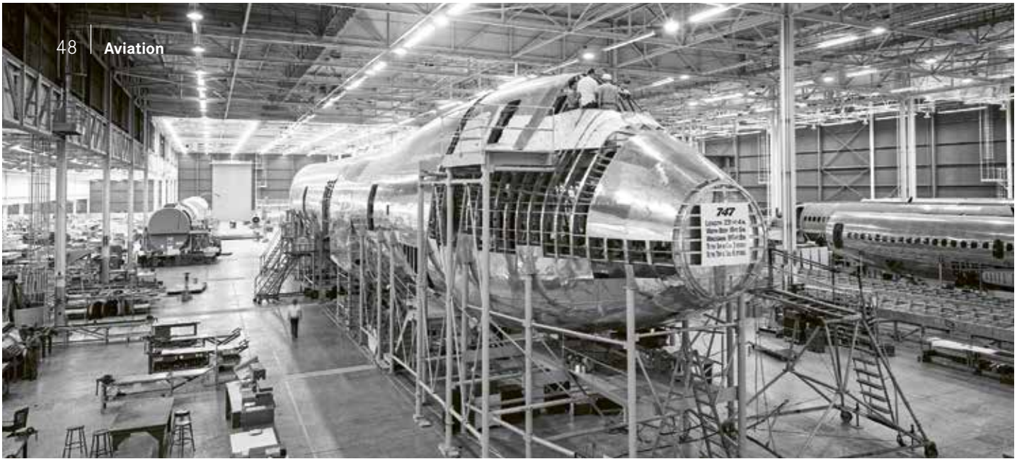
Produktionsstätte in Everett — Drei Stockwerke über dem Boden stehen diese Arbeiter im Cockpitbereich des Mock-Ups der 747 in Originalgröße im Dezember 1966.
